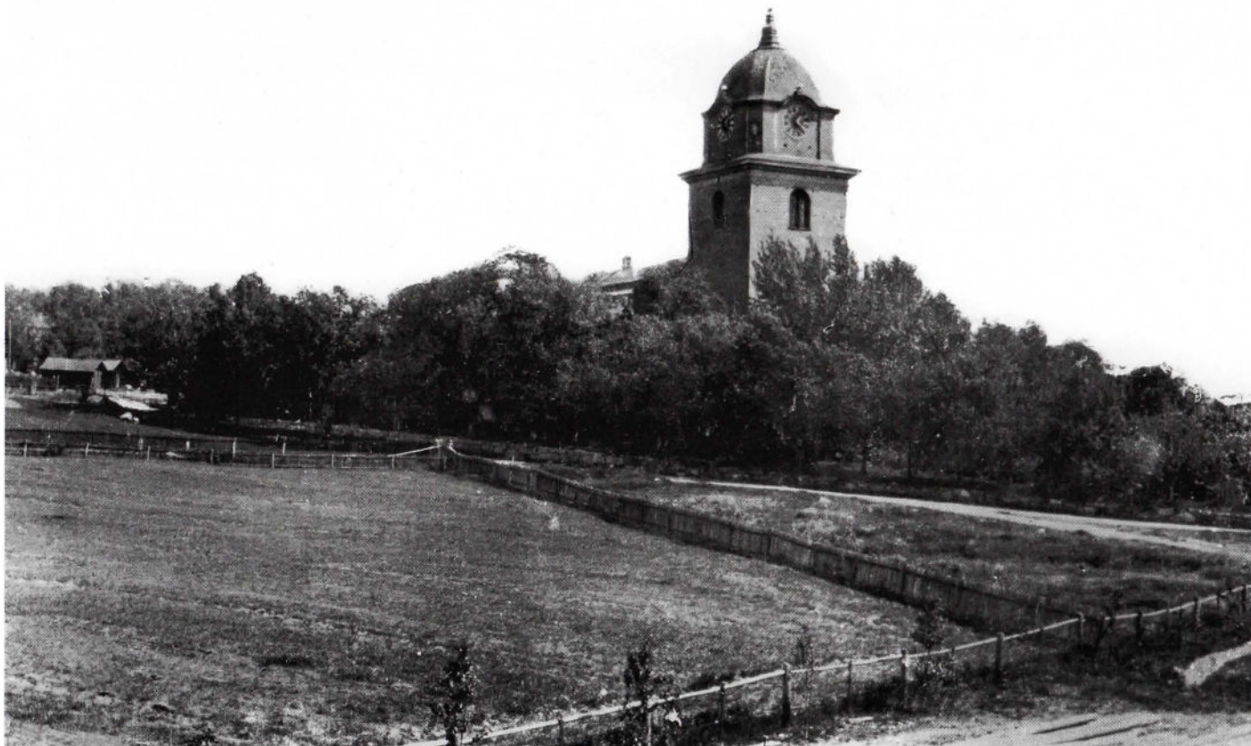
Stora Kopparbergs kyrka före restaureringen 1898.
